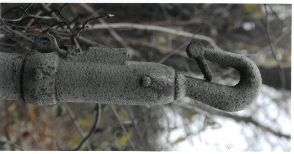
Słupek w ogrodzeniu po stronie południowej
