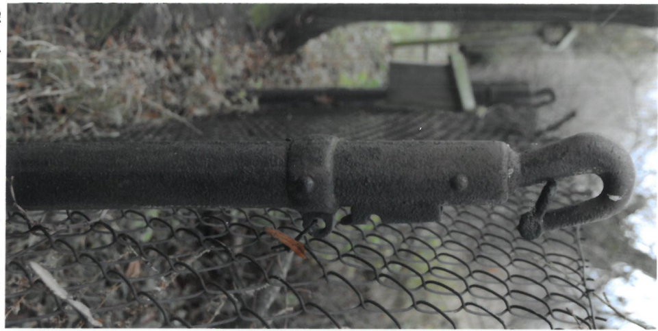
Słupek w ogrodzeniu po stronie południowej
