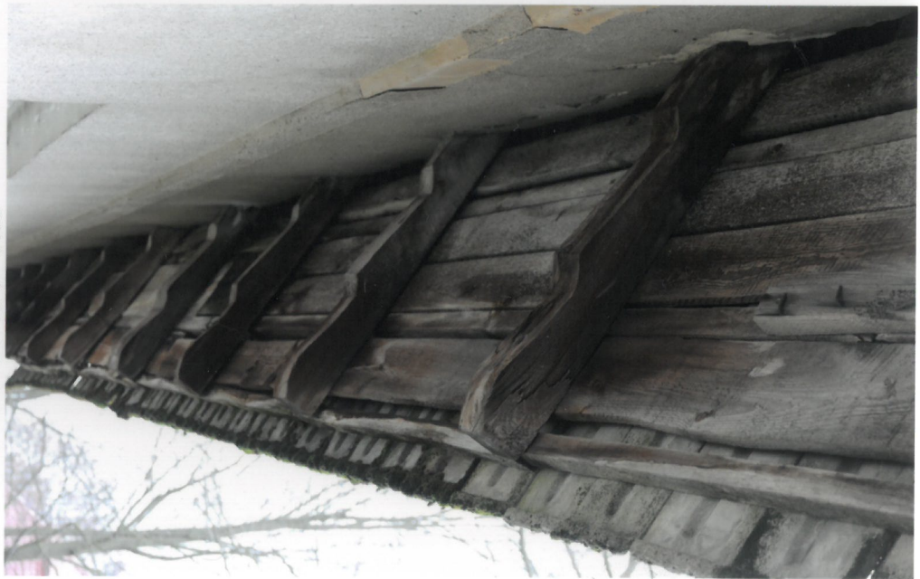
Widok na belki więźby dachowej
