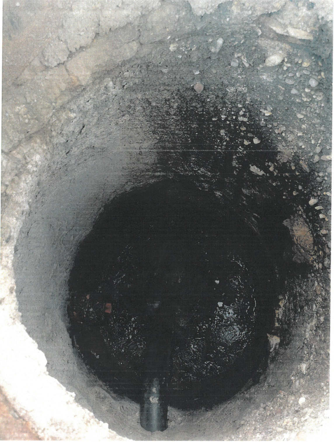
Studnia rozprężna SR1 ul. Marii Konopnickiej przy posesji nr 15
