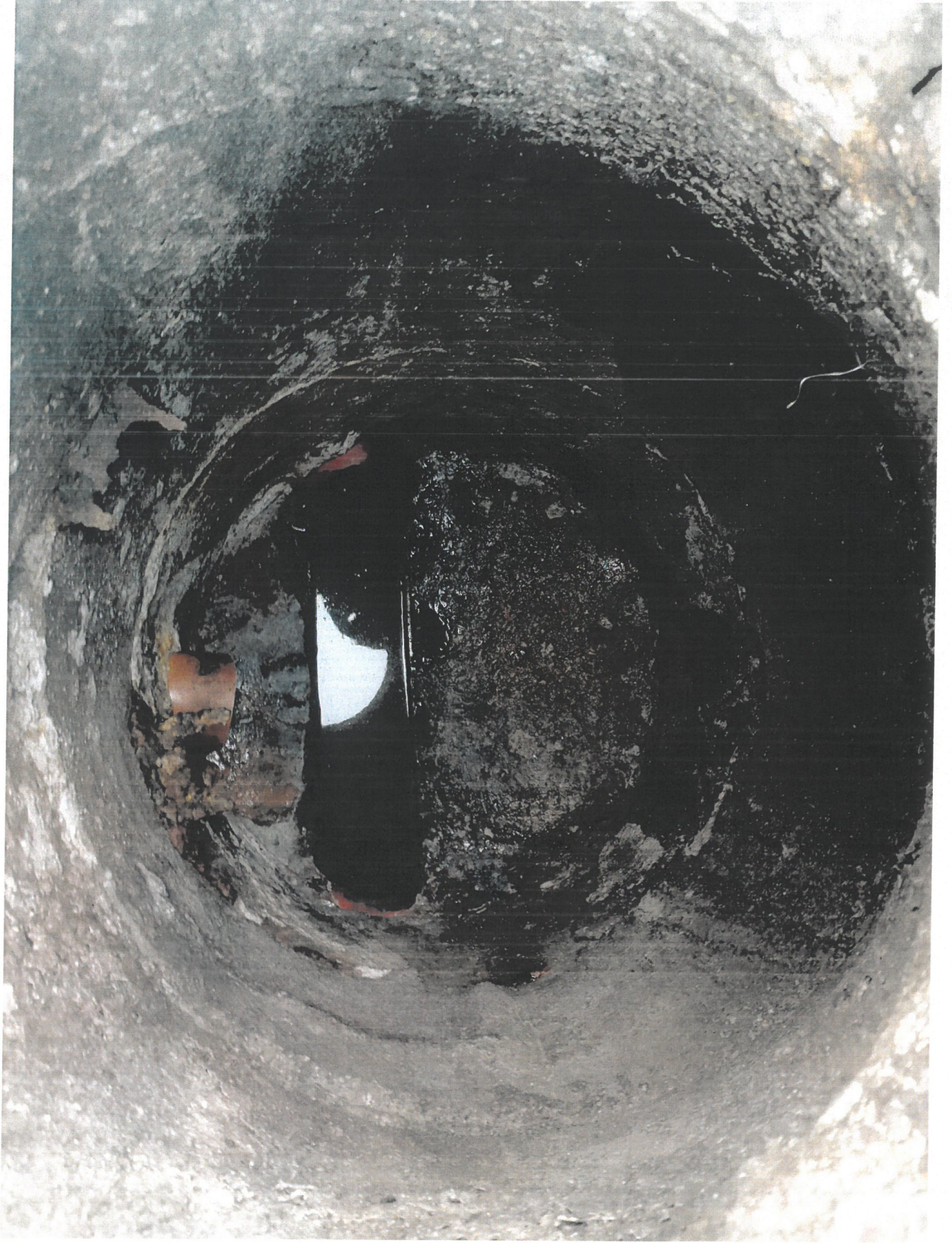
Studnia ul. Marii Konopnickiej przy posesji 20
