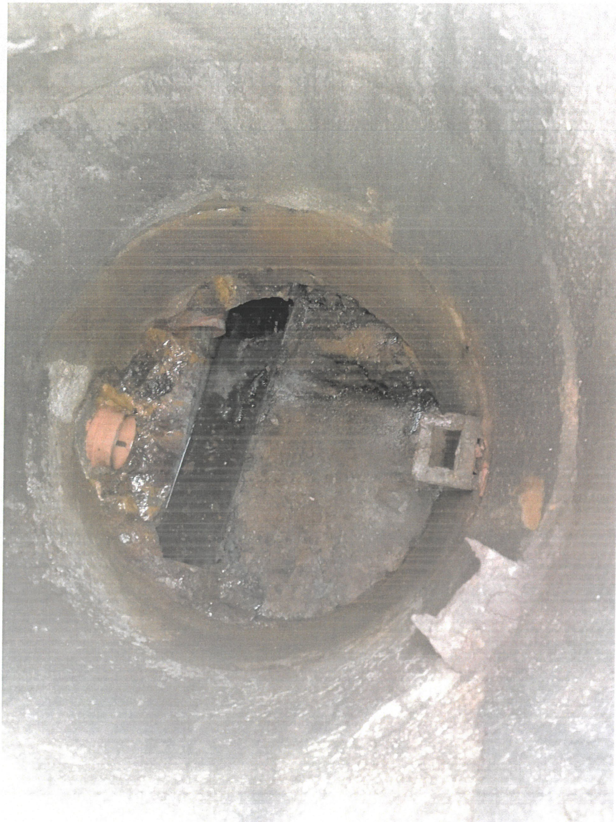
Studnia ul. Marii Konopnickiej przy posesji 21
