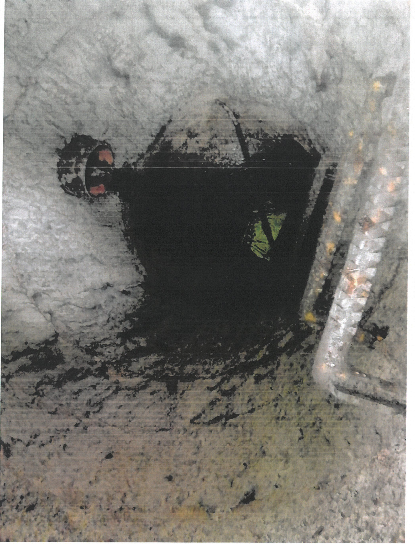
Studnia kanalizacyjna w miejscowości Wolica
