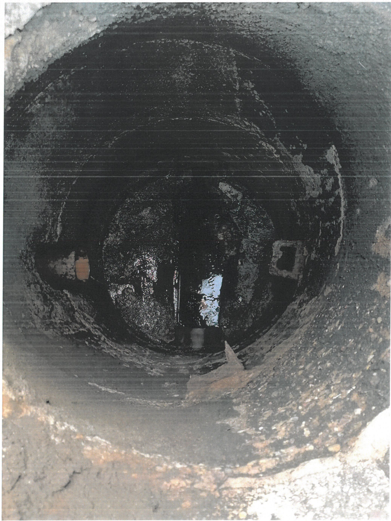
Studnia ul. Marii Konopnickiej przy posesji 23
